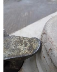
Foto 1: aanslaglip drukt tegen sponning.
