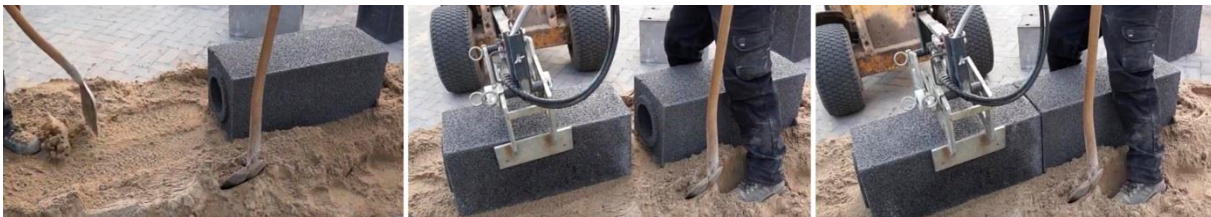
Foto's: leggen Permeoblokken
