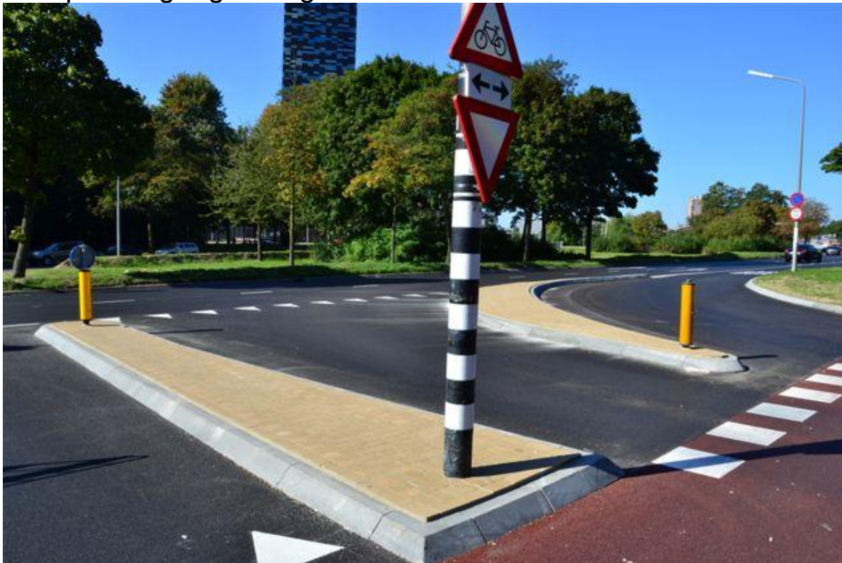
VoegStones van De Hamer: de duurzame onkruidvrije oplossing bij het aanleggen van bestrating.
